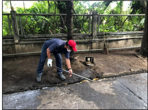
รูปที่ 18 การขุดลอกรางระบายน้ำ
