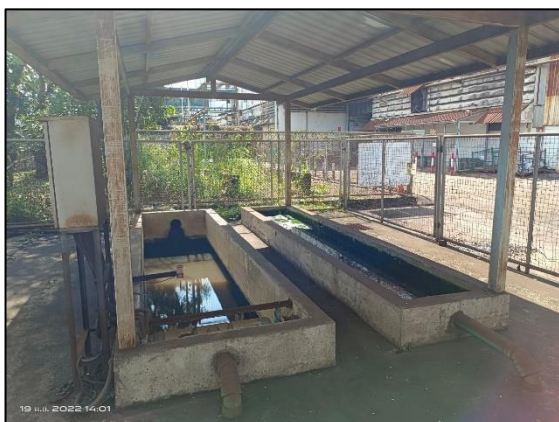
รูปที่ 15 บ่อพักน้ำหลังผ่านการบำบัด
